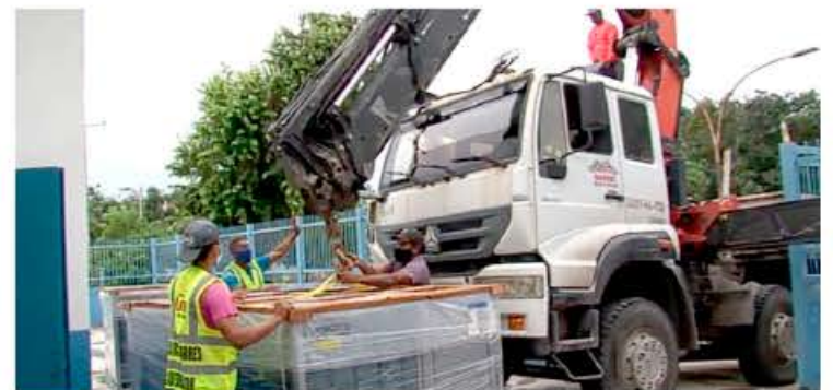
El Gobierno Bolivariano realizó la dotación de nueve unidades de aire acondicionado centrales para mejorar la climatización del hospital FOTO CORTESÍA CONSTRUARAGUA
