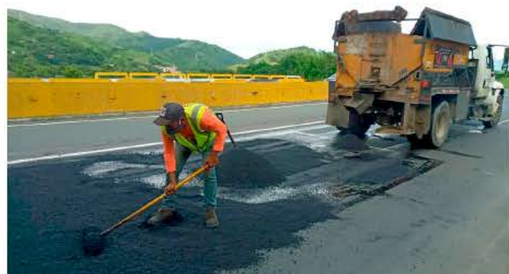
En la ARC se llevan a cabo labores de corrección de baches FOTOS CORTESÍA VÍAS DE ARAGUA
