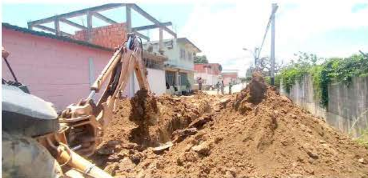
La alcaldesa Sánchez supervisó los trabajos que realizan en el sector Bicentenario FOTOS PRENSA ALCALDÍA DE MARIÑO
