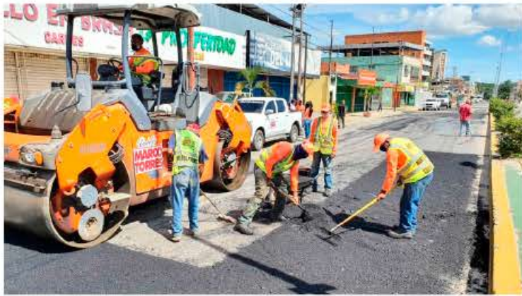
Cuadrillas de asfaltado han sido desplegadas en distintos sectores de El Limón
